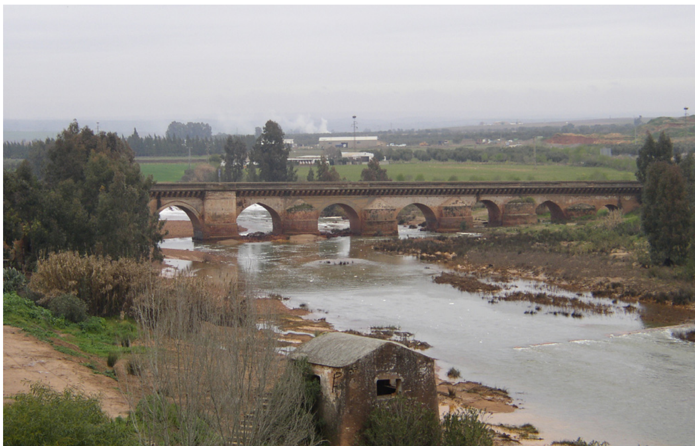
Puente romano desde el sur
