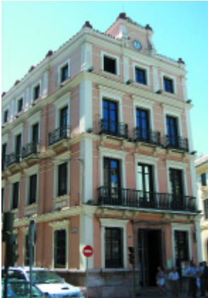
Edificio San Luis-Delegación de Cultura del Ayuntamiento de Antequera, Málaga
