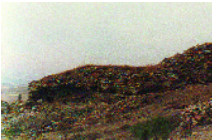
Muralla medieval de Alarcos antes de su restauración
