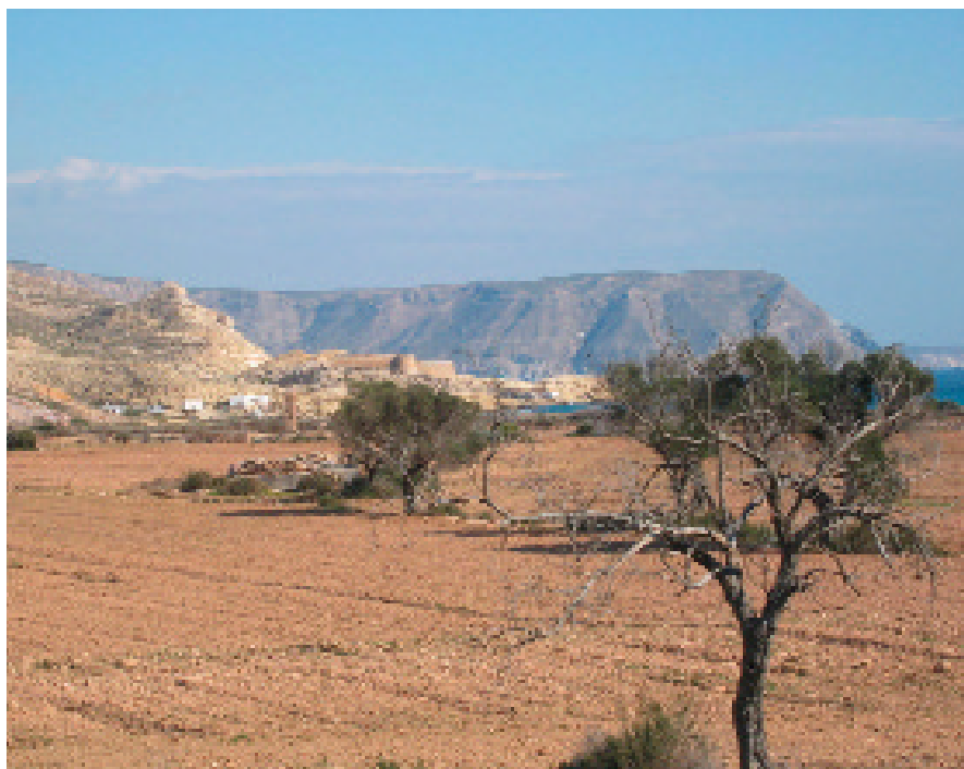
Bateria de San Ramón, en Rodalquilar, Parque Natural de Cabo de Gata-Níjar
