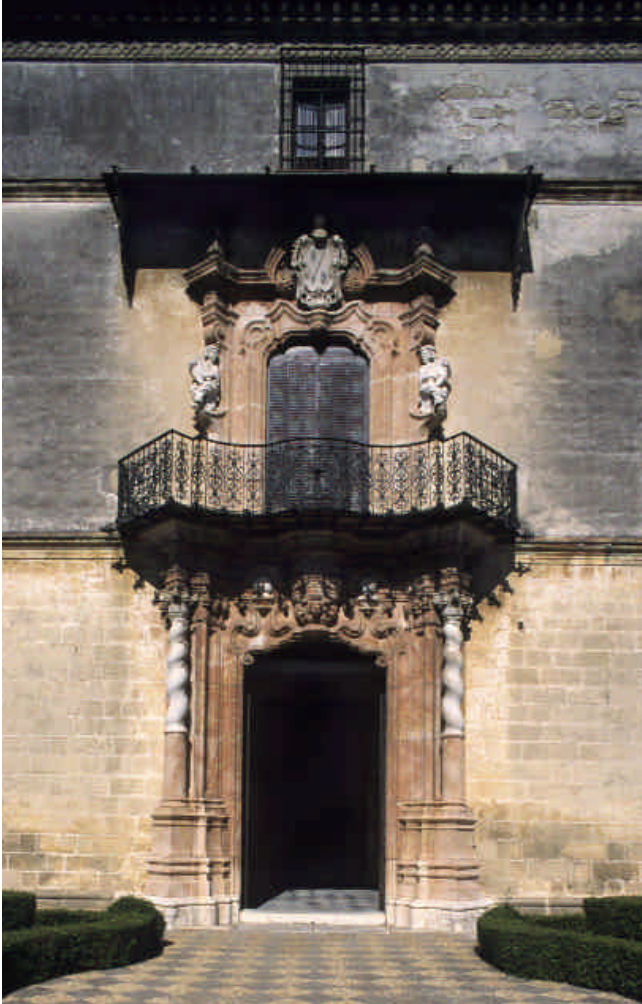
❖ Portada principal del palacio barroco de los Marqueses de Montaña, Palacio Domecq, en la zona de salida hacia Sevilla de la ciudad histórica / JAVIER ROMERO, IAPH
