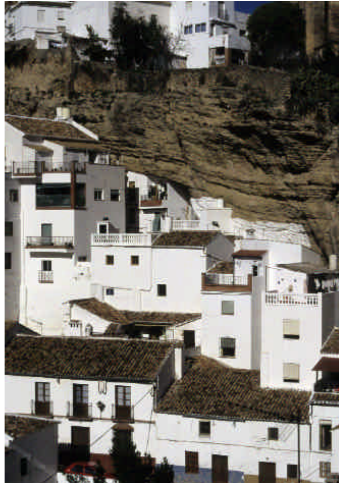
W Setenil de las Bodegas. Casas excavadas en la piedra / JAVIER ROMERO, IAPH
