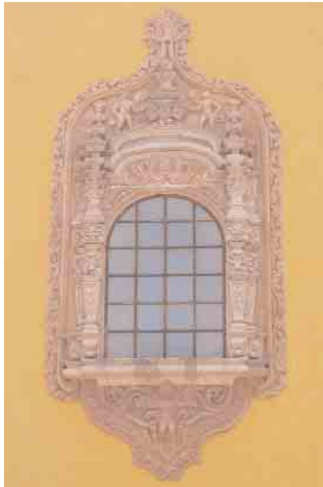
📍 Vista de la ventana barroca de la Capilla de Aránzazu del ex Convento de San Francisco en San Luis Potosí
