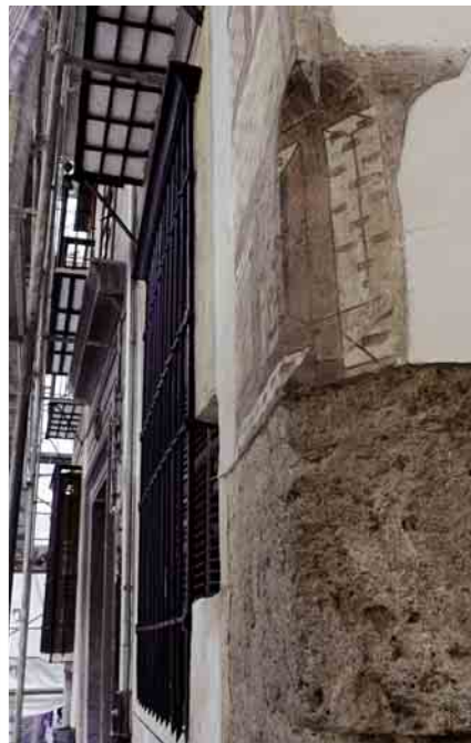
📍 Casa 17. Las rejas, la del fondo, volada, y la que aparece en primer lugar, borneada al plano de la fachada, ajustada a las Ordenanzas de Madrid de Juan Torija (1760), indican intervenciones que afectaron a la decoración original, avanzada la segunda mitad del siglo XVIII / FOTO: JUAN CARLOS CAZALLA, IAPH
