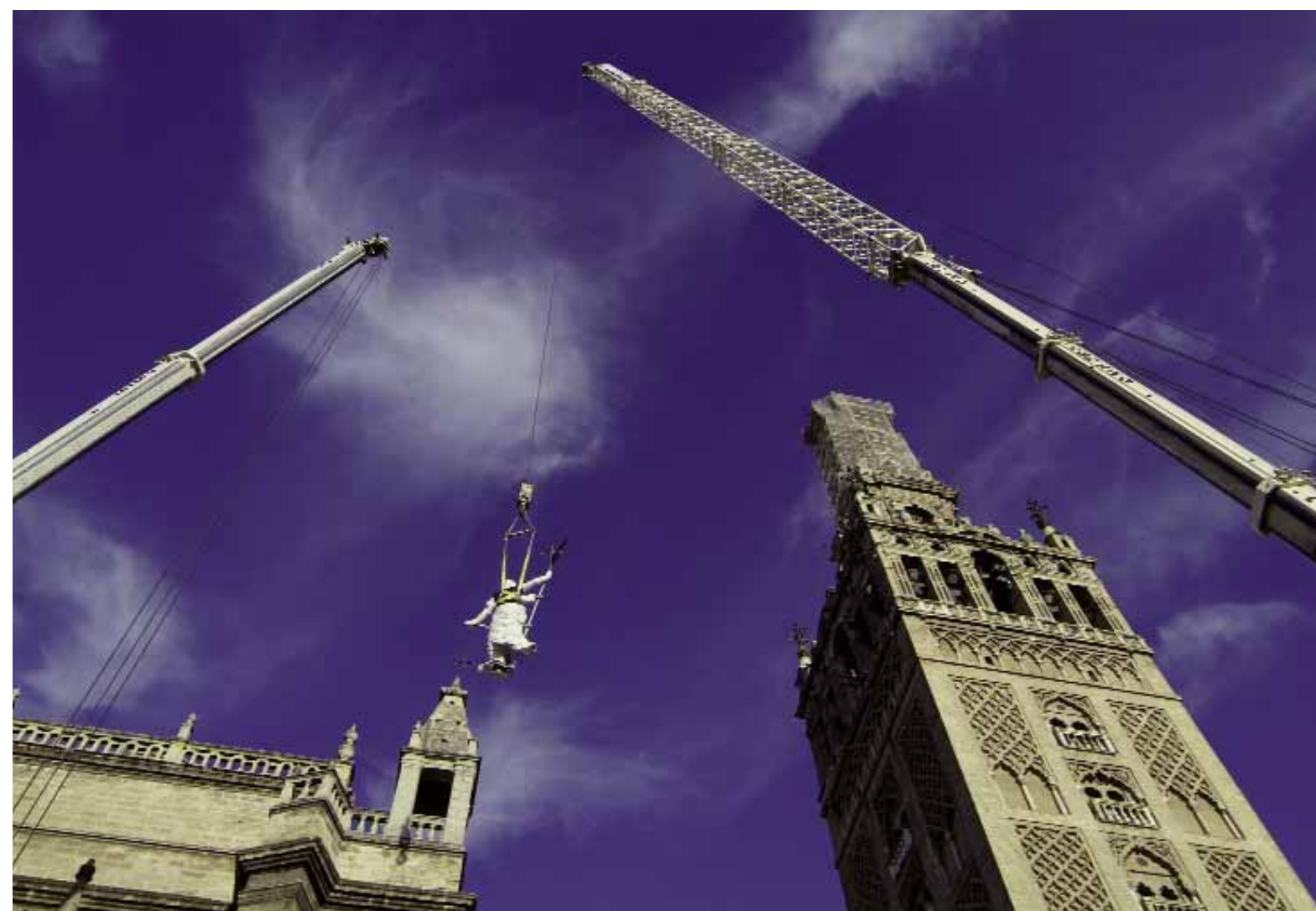
🕒 El Giraldillo durante su reposición sobre la Giralda / FOTO: JOSÉ MANUEL SANTOS MADRID, IAPH
