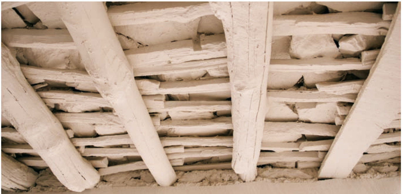
Techo de vigas de madera de un tinajo de Pampaneira (La Alpujarra). Foto: Juan Carlos Cazalla, IAPH
