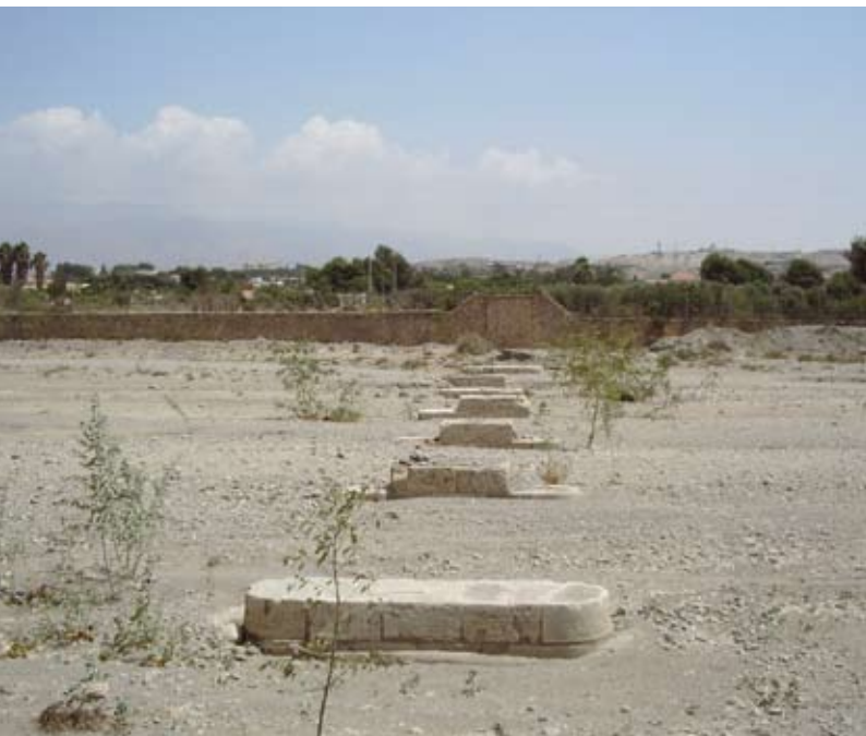
Vestigios del puente del río Andarax. Pilastras de apoyo y estribos de mampostería. Fuente: Fondo ASAFAL
