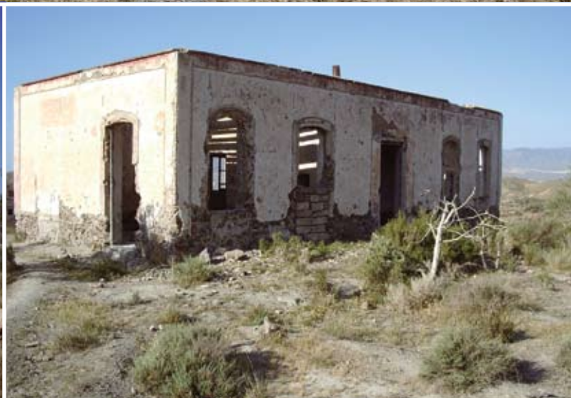
Estado actual del edificio de viajeros de El Chorrillo. Fuente: Fondo ASAFAL
