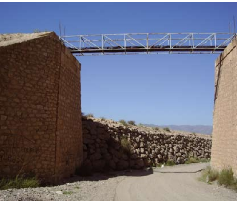
Puente de la rambla de Ayuso. Fuente: Fondo ASAFAL
