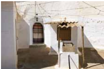
Guadix. Detalle de la entrada de una casa-cueva
