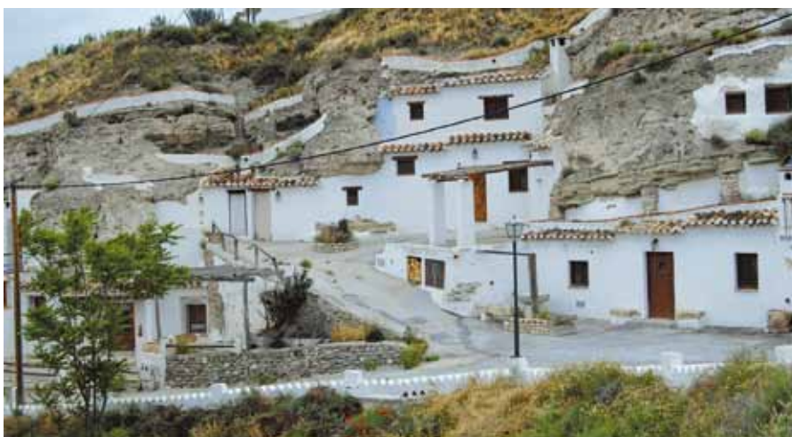
Las casas-cuevas necesitan de pocos recursos para ofrecer unas condiciones óptimas de habitabilidad. En la imagen casas-cuevas de Galera
