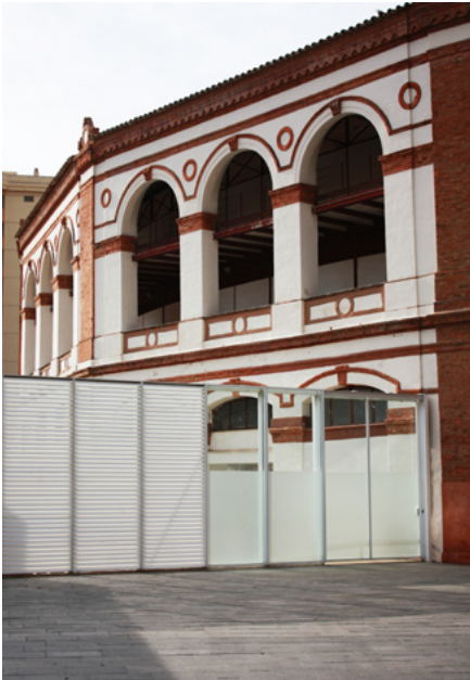
Puerta de acceso peatonal a los corrales por el paseo de Reding
