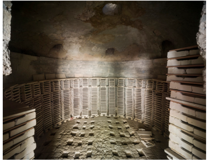
Interior de cámara de cocción del horno n.º 6
