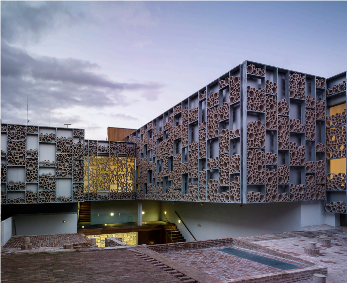
Interior del Centro Cerámica Triana tras la intervención | foto Jesús Granada
