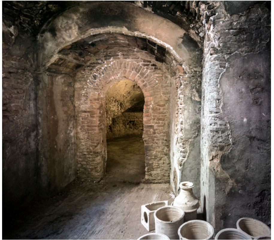
Cámara de combustión o caldera | foto Jesús Granada
