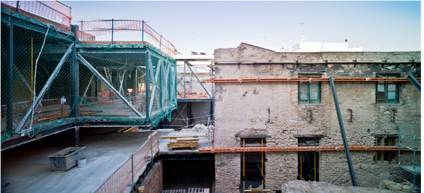
Estructuras nuevas y existentes. En construcción | foto Javier Orive
