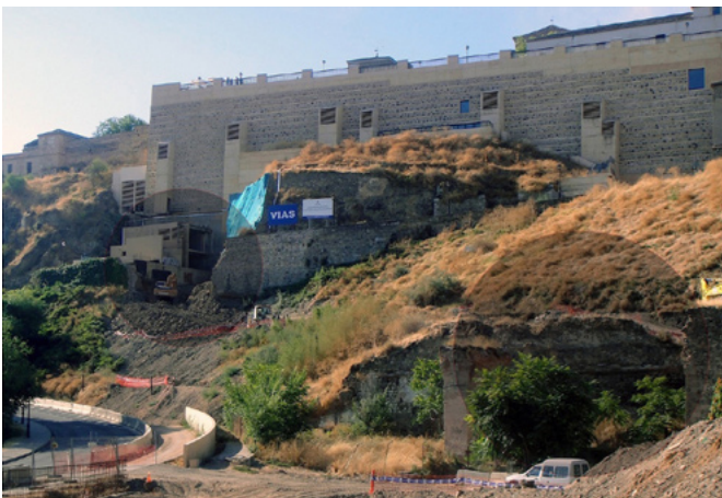
Desarrollo de las obras de demolición del torreón y su relación con las ruinas del convento de San Pablo (2012-2013) | fotos Arturo Ruiz Taboada
