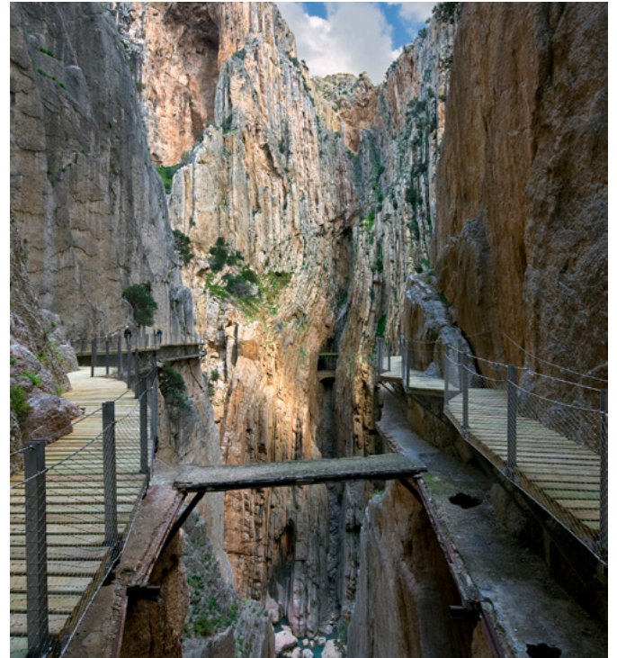
Desfiladero de los Gaitanes | fotos Duccio Malagamba
