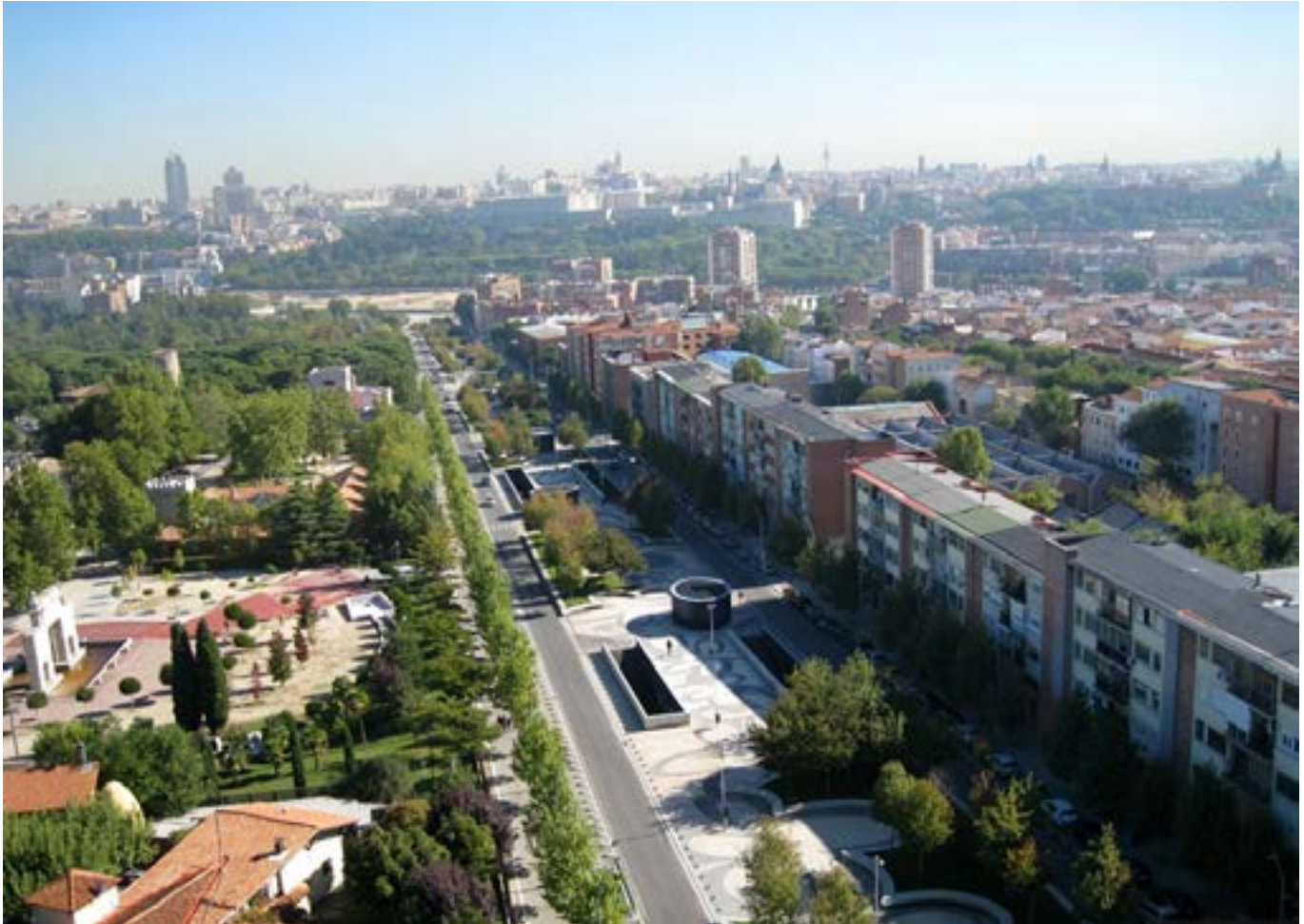
Avenida de Portugal después de la intervención | foto Ayuntamiento de Madrid
