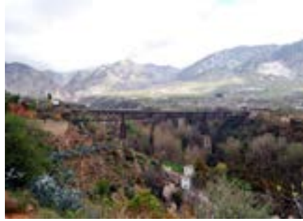
El puente de Lata sobre el río Dúrcal. Al fondo, Los Alayos y sierra de El Zahor
