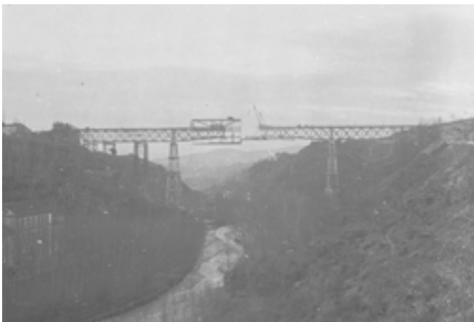
Operaciones finales de montaje del puente en Dúrcal. José Martínez Rioboo, 1925 | foto Fundación Rodríguez-Acosta. Donación Martínez Sola
