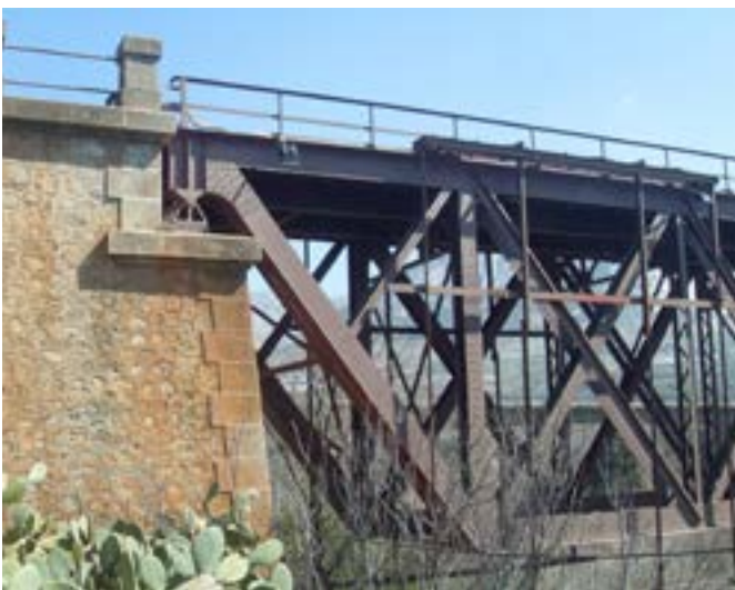
Detalle del extremo de las vigas y aparato de apoyo
