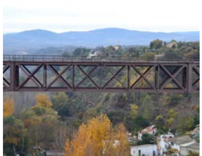
Vigas del puente, detalle del tramo en cantilévér
