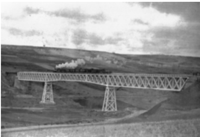
El puente en su ubicación original. Gor, hacia 1909 | foto Cortesía de Encarnación López Sánchez. Asociación cultural Amigos de Gor
