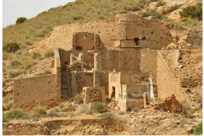
A la izquierda, instalaciones auxiliares junto a la bocamina de Las Niñas, mina en la que se descubrió oficialmente el oro de Rodalquilar en el año 1883; a la derecha instalación metalúrgica de amalgamación de la mina María Josefa, levantada bajo la tutela de Juan López Soler a mediados de la década de 1920
