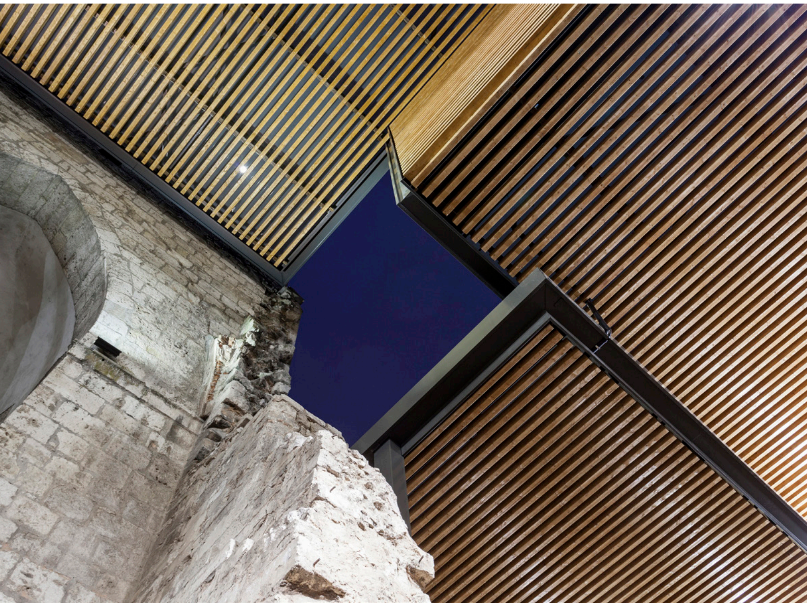
Detalle de la nueva cubierta para el monasterio de San Juan (Burgos) | foto todas las imágenes que ilustran este artículo son de Santiago Escribano Martínez, excepto si se indica lo contrario
