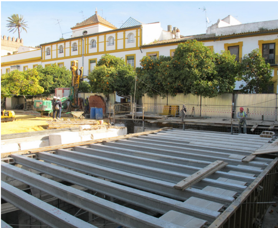
Imágenes durante la ejecución de las estructuras. Construcción del forjado | fotos estudio Francisco Reina
