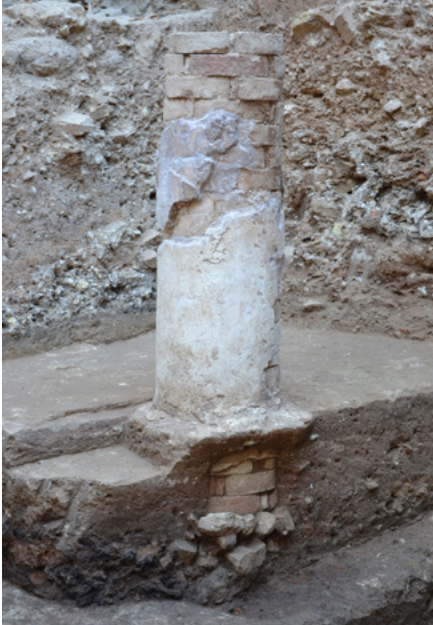
Columna de ladrillo, con restos de revestimiento, perteneciente a la crujía sur y muro de adobe | fotos Miguel Ángel Tabales
