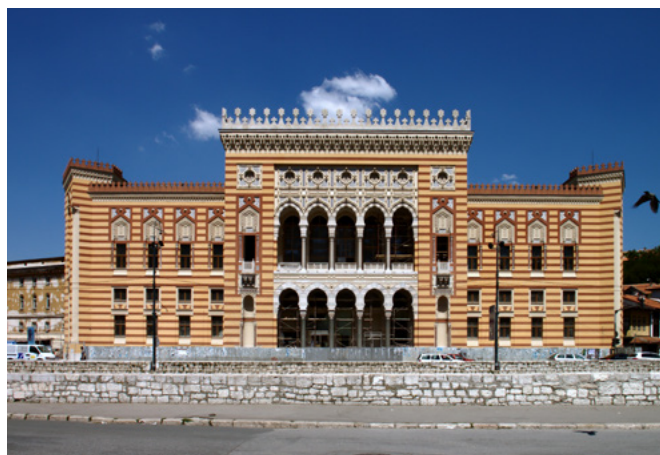
Casi terminada la reconstrucción del edificio del Ayuntamiento como Biblioteca Nacional de Sarajevo | foto Aktron
