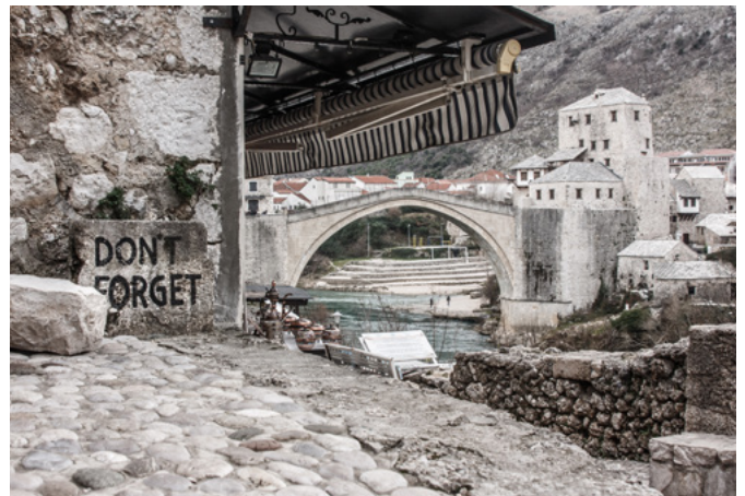
Puente de Mostar tras su reconstrucción | foto Omer Tarik Koc
