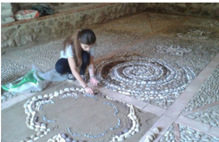
Empedrado de la ermita de San Marcos
