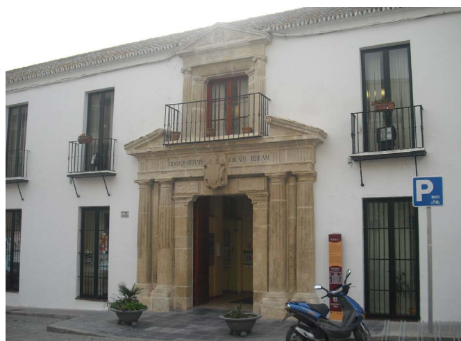
Fachada del antiguo cabildo y cilla municipal
