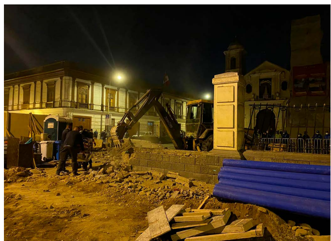
Demolición del cerco perimétrico de la Plazuela de San Francisco, en Lima (2022) | foto Archivo de la Orden Franciscana
