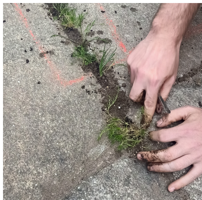
Pablo Rodeiro y Miguel Serrano (derecha e izquierda, respectivamente) en la Plaza de Fuenterrabía instalando parcelas de seguimiento con diversas combinaciones de plántulas y semillas de especies vegetales resistentes al tránsito, en juntas de pavimento habilitadas con sustrato apropiado e implantación de las especies en las zonas de estudio del casco histórico de Santiago de Compostela (imagen derecha) | fotos ACBiodiv (GI-1291)
