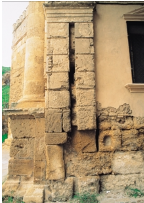
La ranura para el rastrillo de la puerta romana, conservada en la primera hilada, fue reproducida en la Puerta neoclásica.
