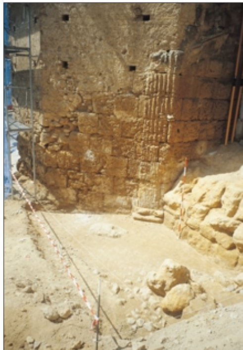
Torre y Lienzo Norte durante la intervención de 1999.
