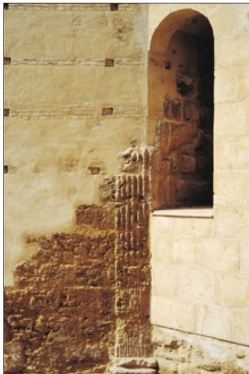
Fig. 10. Estado del lienzo norte al inicio de la obra.
