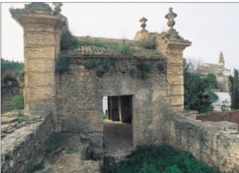
Fig. 18 y 19. Aspecto parcial de las cubiertas antes y después de la intervención.
