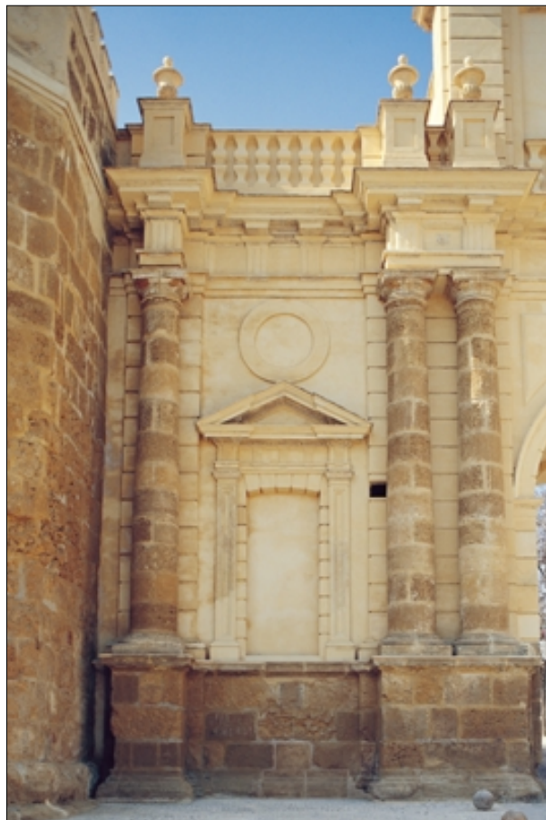
4. Vista de la fachada este una vez concluidas las distintas fases de restauración, se pueden observar la reposición de piedra, mortero y reintegración por medio de veladuras.
