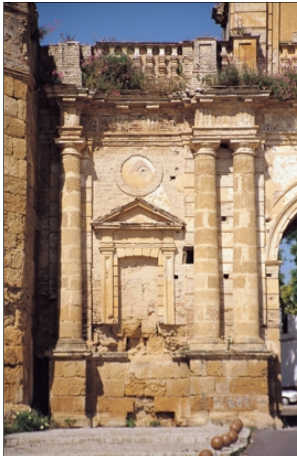
3. Fachada este, lateral izquierdo antes de iniciar la intervención.
