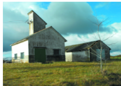
Estacion de Bombeo en Arneiro
