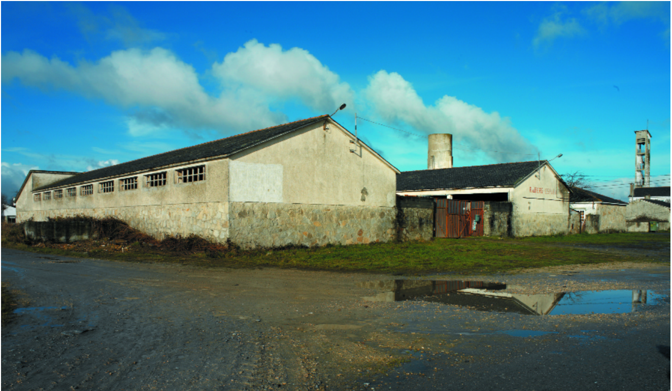
Parque de maquinaria en Arneiro
