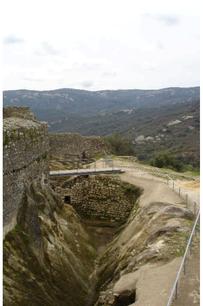
W Intervención. Pasarela y protecciones / FRANCISCO REINA
