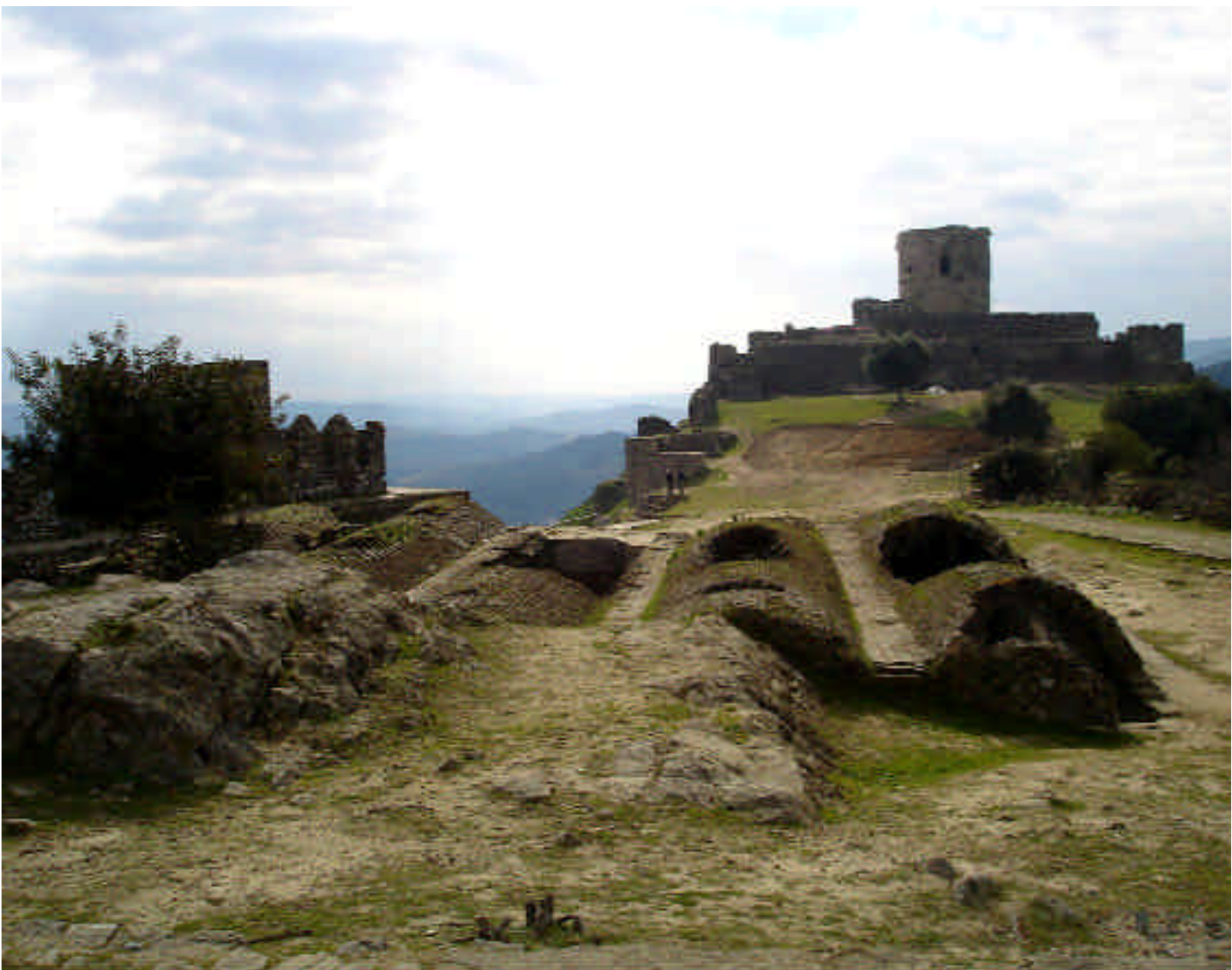
W Vista general hacia el sur del Castillo de Jimena de la Frontera. Aljibe almohade, puerta del reloj y al fondo el Alcázar / FRANCISCO REINA
