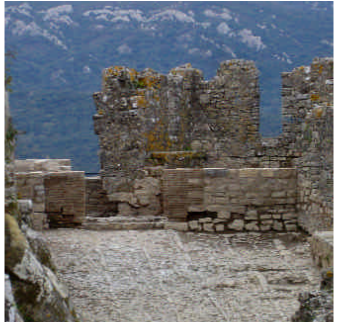
W Rampas y sistema de acceso original tras la intervención de 2004 / FRANCISCO REINA
