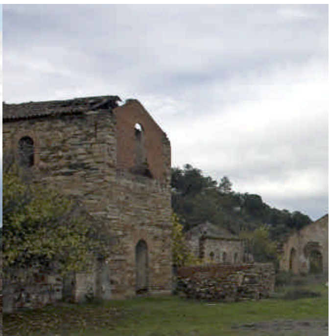
X Pozo Mirador. Poblado de El Centenillo (Baños de la Encina) / JAVIER ROMERO, IAPH
