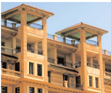
📍 Antiguo Hotel Miramar (Málaga) / JUAN CARLOS CAZALLA, IAPH
