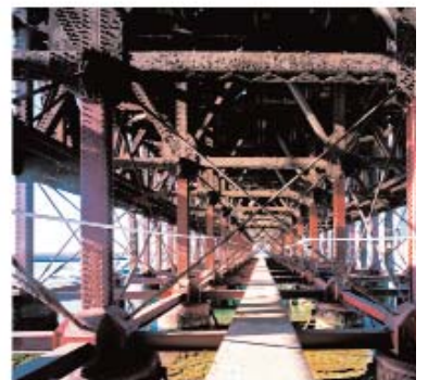
INTERIOR DEL MUELLE DE CARGA A NIVEL DEL MAR C/ PILOTES. LA RETÍCULA DE VIGAS DE ATADO Y LOS ELI DE LA ESTRUCTURA
