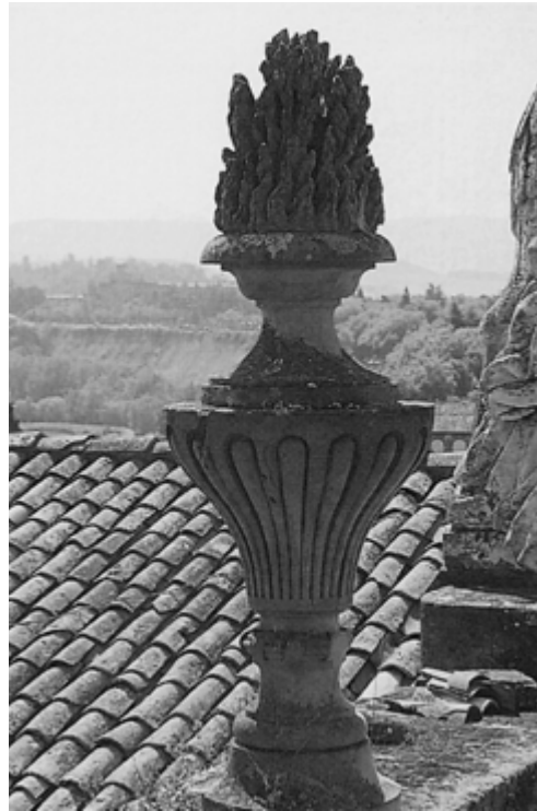
2. Jarrones que adornan la fachada Oeste del Templo de la Catedral de Pamplona. Los líquenes, organismos capaces de desarrollarse sobre cualquier tipo de superficie, se muestran más activos en su desarrollo sobre superficies horizontales, y en exposiciones con grado de humedad más elevado.
