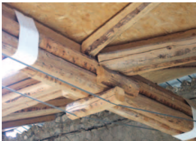
Herculaneum Conservation Project. Solución de las cubiertas en 2007. Fotos: Lucía Gómez Robles
