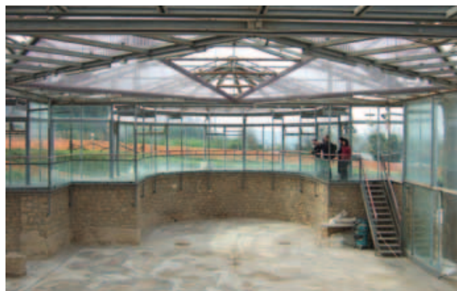
Interior del triclinium de la villa del Casale en Piazza Armerina con la cubierta de Franco Minissi. Foto: Lucía Gómez Robles
