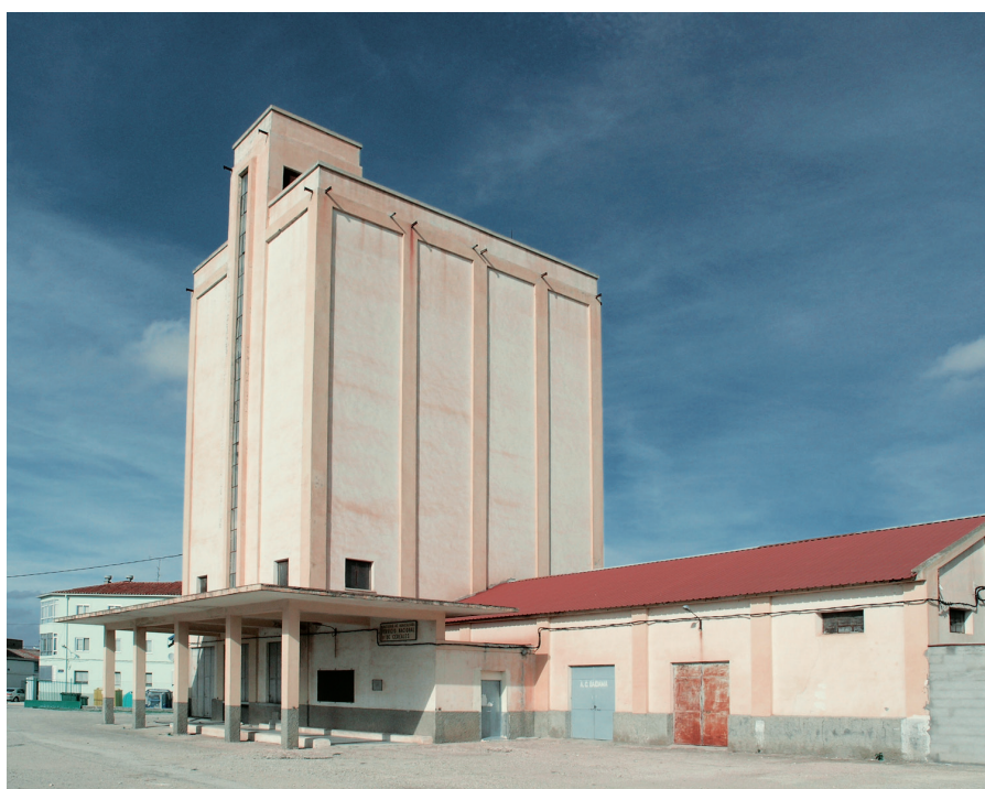
Silo de Mahora (Albacete). Fuente: Archivo silosygraneros.es
