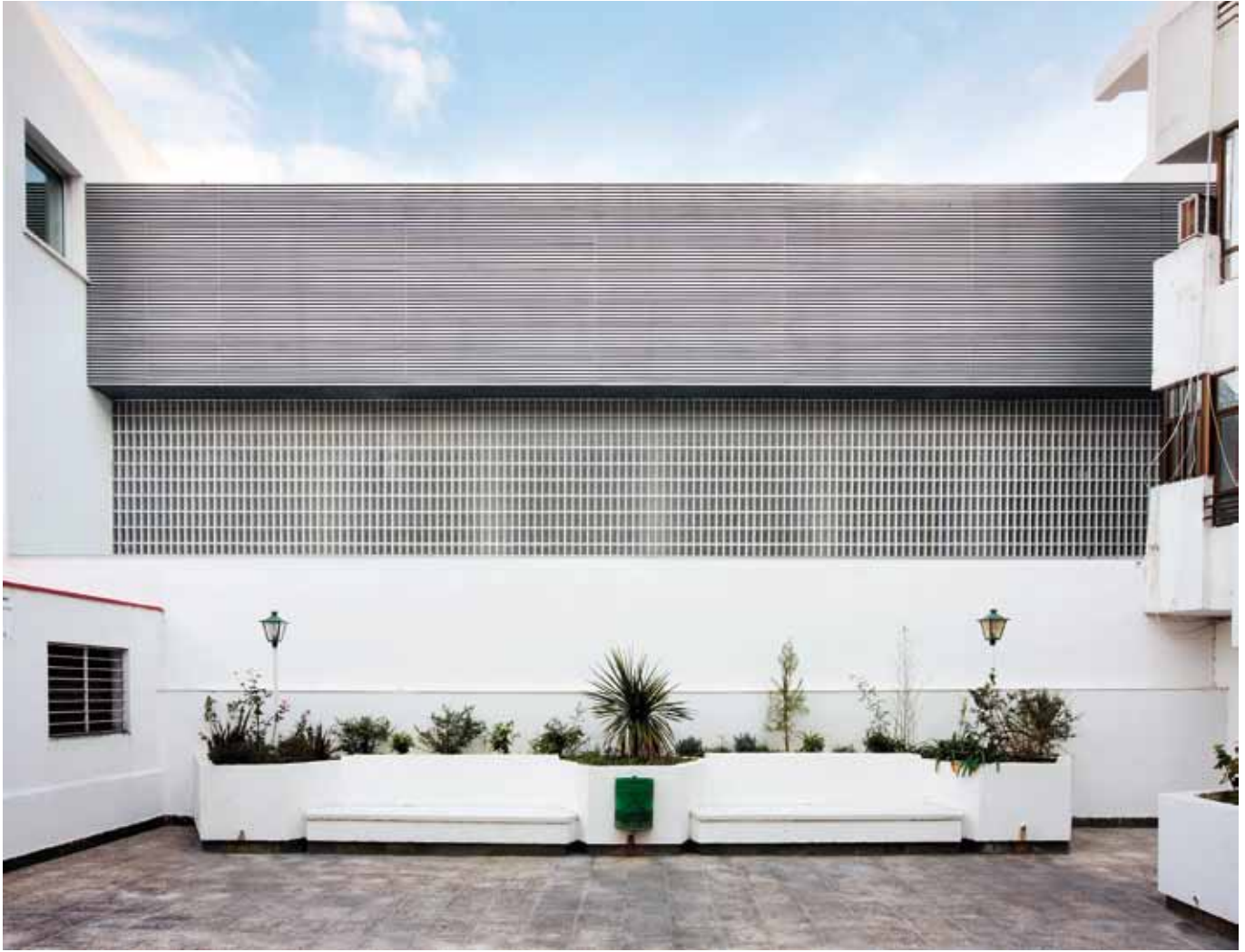
Nueva imagen trasera desde el patio interior de viviendas
