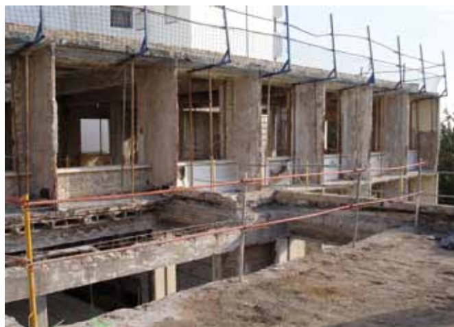
Trabajos sobre la estructura portante
