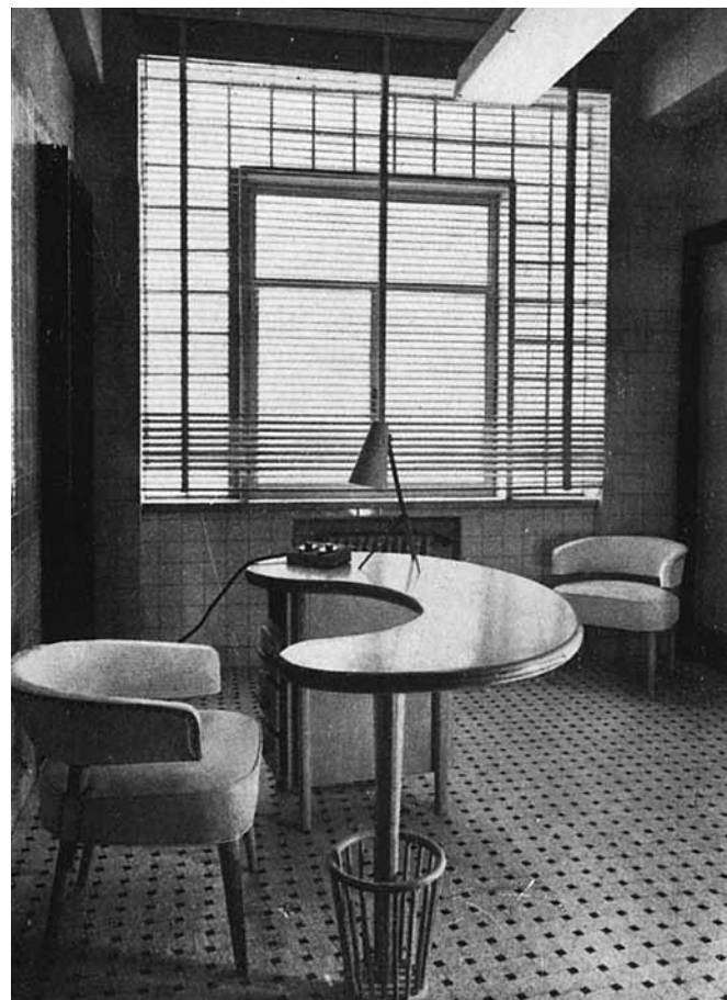
Interior de la consulta tipo del ambulatorio Hermanos Laulhé (1954). Fuente: CAVESTANY, 1954
