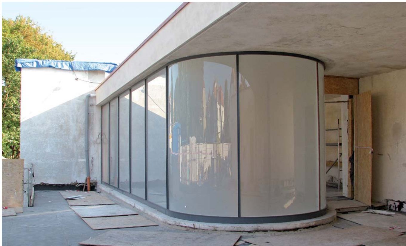
Casa Tugendhat (situación actual), tras instalar la nueva pared de vidrio esmerilado de la zona de entrada, 3 de septiembre de 2011. Foto: Ivo Hammer
