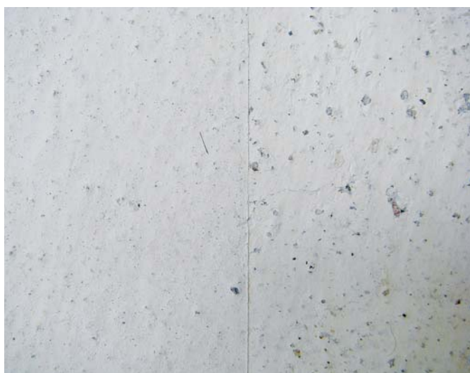
Casa Tugendhat, terraza superior, fachada. Detalle de la superficie original y una muestra de cal reciente de 2011, que se pigmenta con las partículas finas de arena regional. La lechada de cal original de color blanco amarillento en la pared rallada es tan delgada que el color de los granos de arena juegan un papel en el color general del mortero. Fotos: HAVK / Hammer (izquierda) y Hitzler (derecha)
