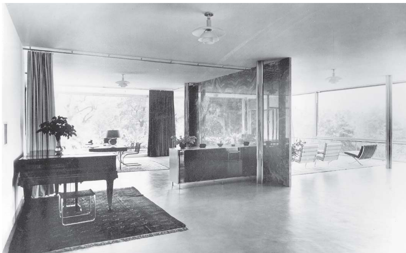
Vista de la sala principal de la Casa Tugendhat desde el sureste. El estuco lustro de la pared tiene una capa de acabado brillante similar al famoso "marmorino", que refleja las superficies. Foto: Sandalo, 1931
