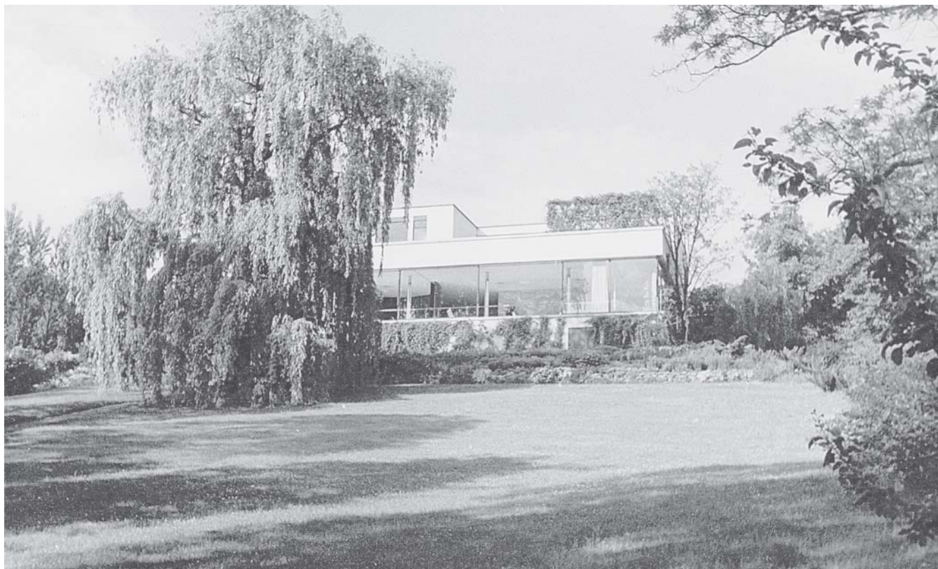
Casa Tugendhat (1928-30. Brno, República Checa) de Ludwig Mies van der Rohe y Lilly Reich. Vista de la vivienda y del jardín desde el sur. La parte inferior de la casa está cubierta de vegetación. Foto: Fritz Tugendhat, hacia 1935 (reproducción: Dieter Reifarth, 2008)
