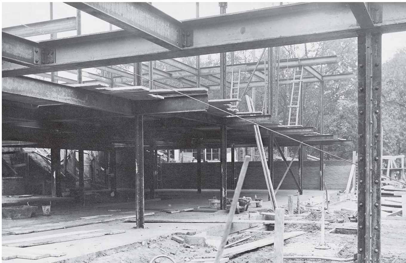
Casa Tugendhat. Marco de acero visto durante la construcción. Foto: Fritz Tugendhat, 1929
