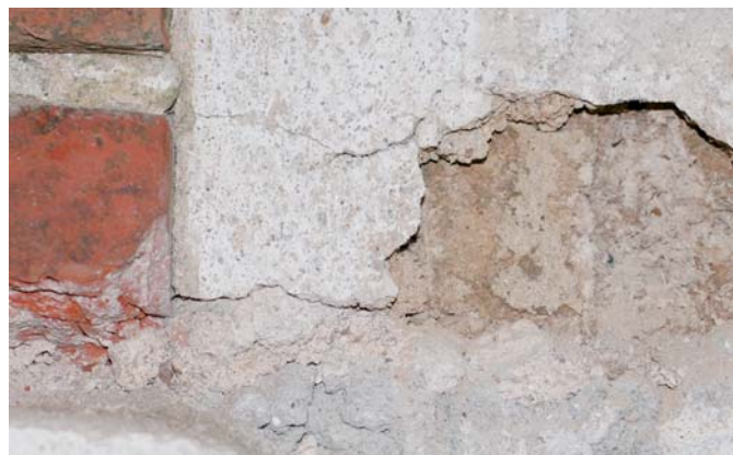
Detalle del muro sur. Fragmento del revoco de la fachada original, que fue suavizado con una tabla de madera y cubierto con una lechada de cal amarillenta. Foto: HAWK/Hammer
