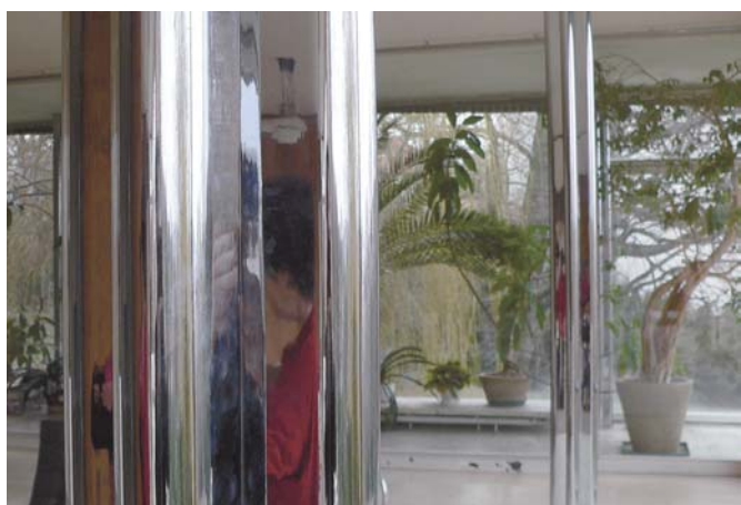
Sala de estar principal, que muestra el detalle del revestimiento de cromo pulido de las columnas de acero en forma de cruz. En el espejo, la sutil desigualdad de la superficie del metal causada por el proceso de fabricación artesanal es claramente visible. Foto: Dieter Reifarh, 2008
