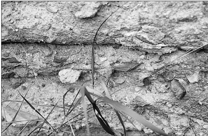
6. Documentación de la fachada interior romana. Las estructuras exhumadas se analizan junto con las emergentes
