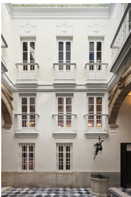
Patio principal. Convivencia de elementos arquitectónicos barrocos y neoclásicos | foto Fernando Alda
