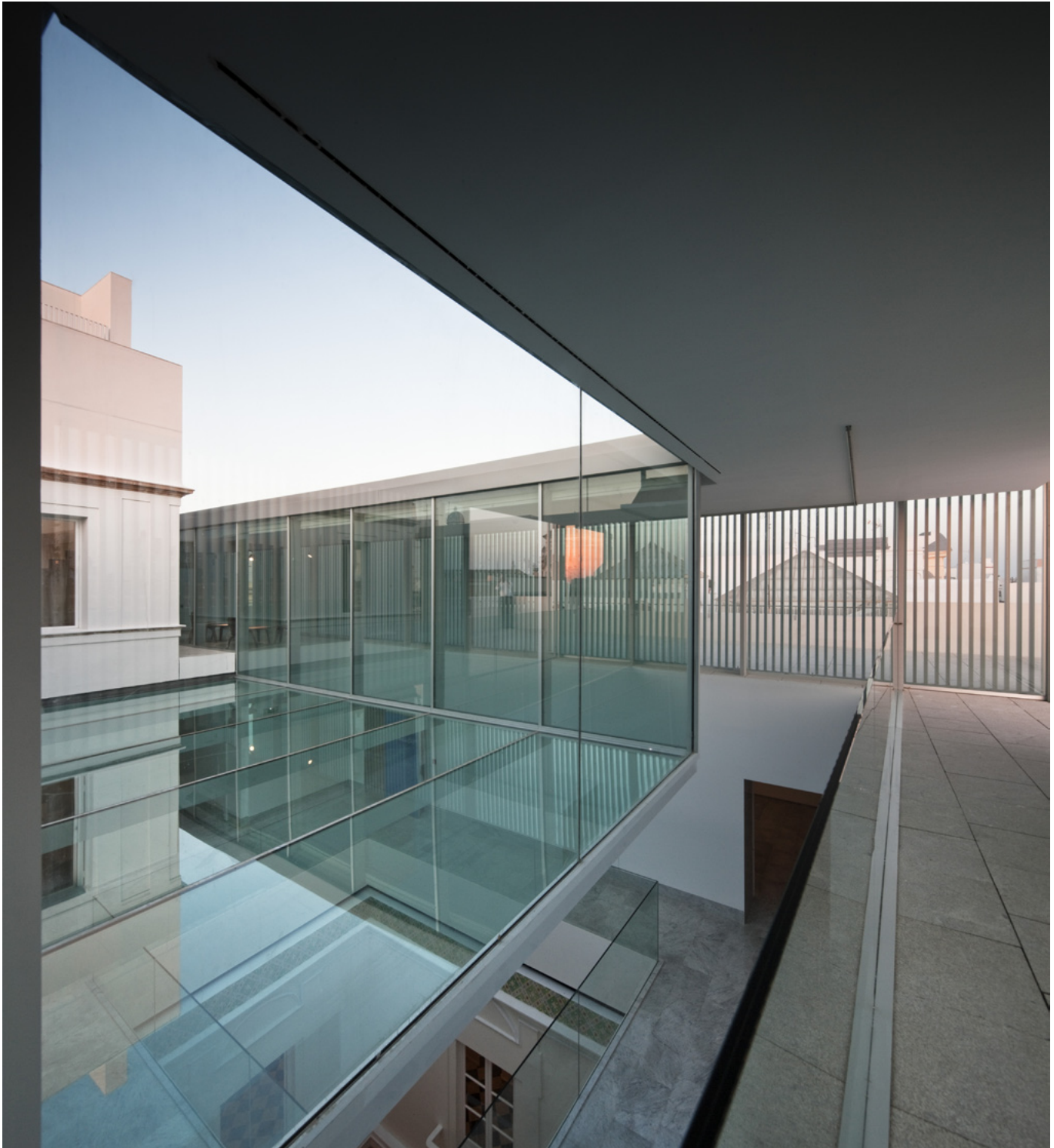
Nivel superior de la montera, acceso a las azoteas | foto Fernando Alda
