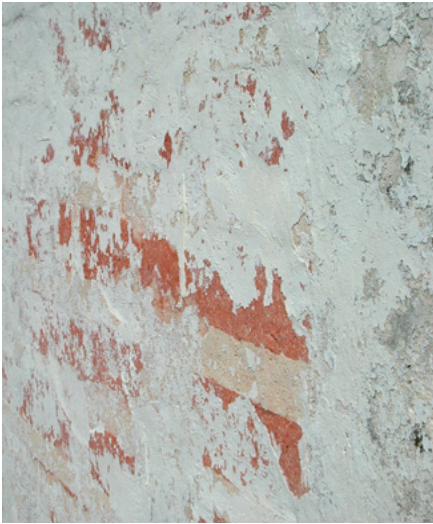
Restos del esgrafiado original en la fachada principal | foto J. Alonso de la Sierra
