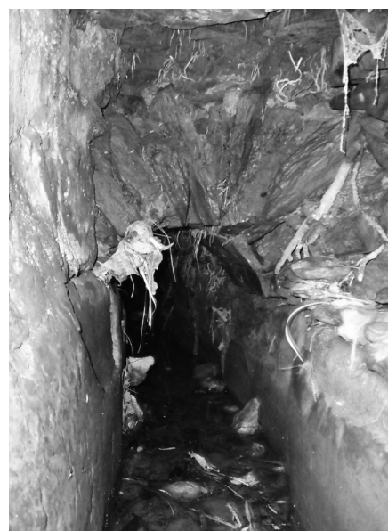
3. Canal excavado en la roca | foto Elena Sánchez López
