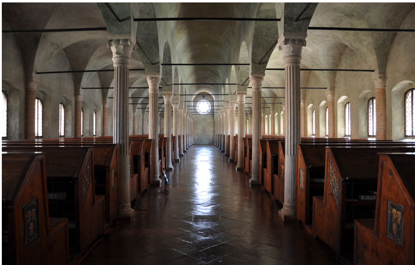
Biblioteca Malatestiana en Cesena (FC), la única parte conservada de un antiguo edificio que ha sobrevivido sin instalaciones (ni calefacción, ni iluminación) | foto Kristian Fabbri
