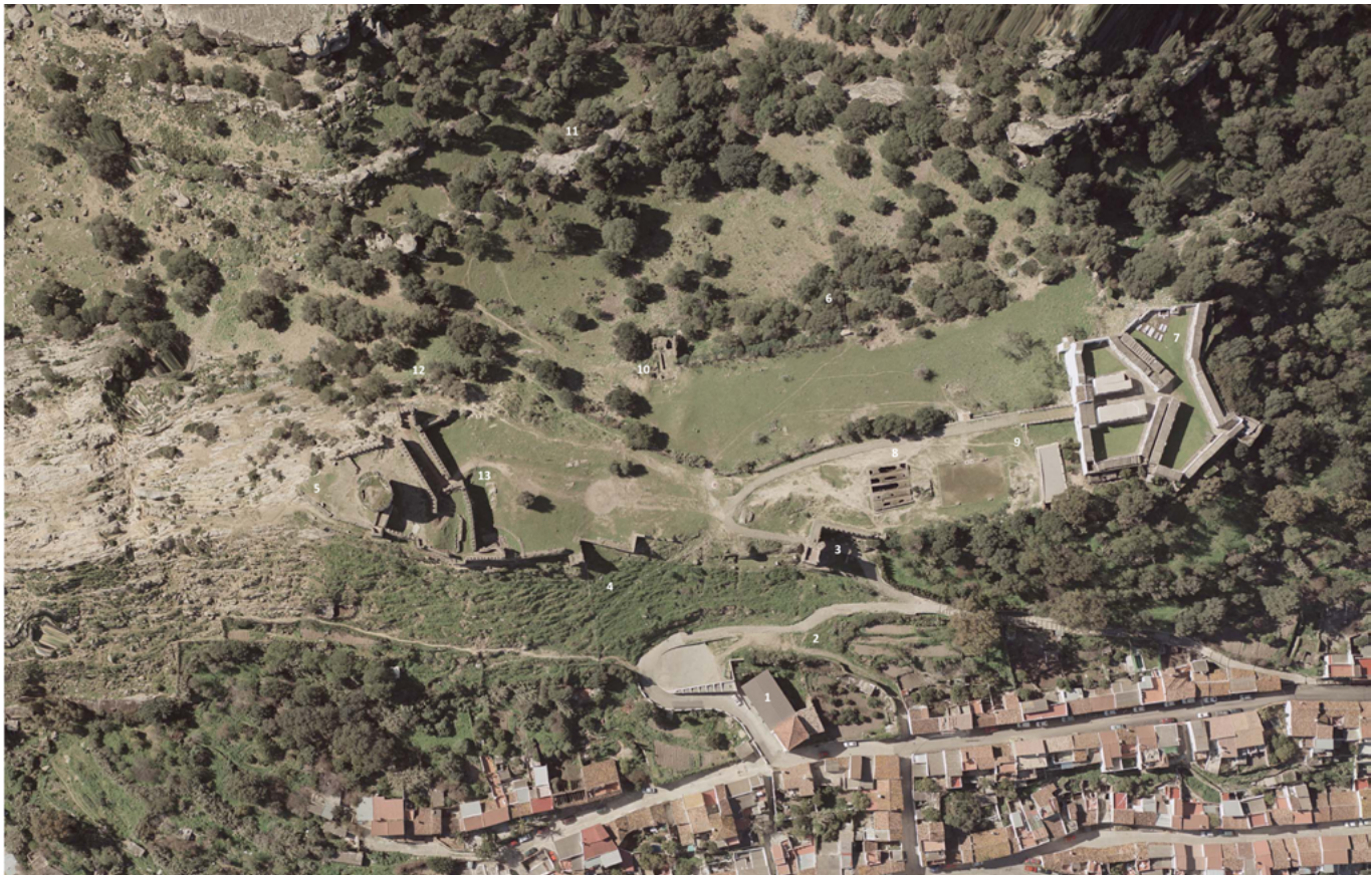
Vista aérea. Estado previo a las obras de 1.ª fase: 1. Iglesia de la Misericordia; 2. Camino histórico; 3. Puerta y torre del Reloj; 4. Ladera oriental. Murallas romanas y medievales; 5. Alcázar. Torre del Homenaje; 6. Ladera occidental. Murallas romanas.; 7. Cementerio; 8. Aljibe almohade; 9. Aljibe medieval; 10. Puerta romana y templo; 11. Yacimiento mozárabe Baños de la Reina Mora; 12. Camino histórico; 13. Foso medieval del alcázar | foto Técnica Cartográfica Andaluza S.A.
