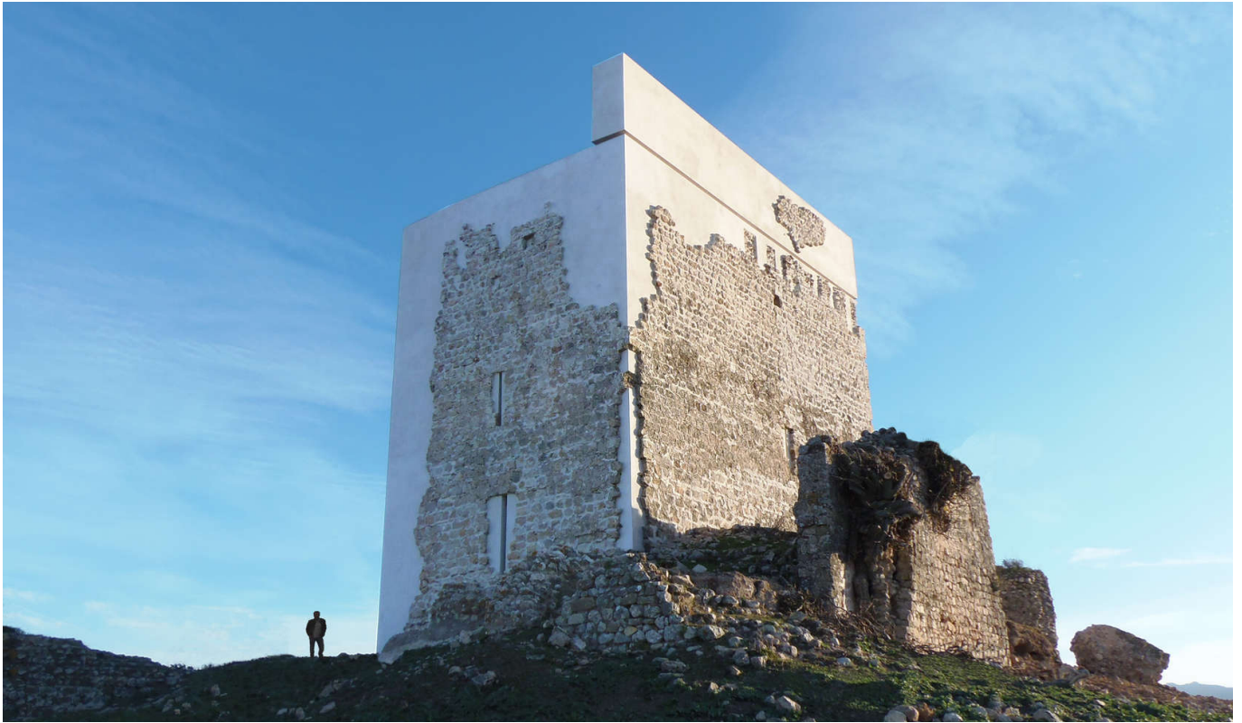
Castillo de Matrera después de su intervención | foto Carquero arquitectura
