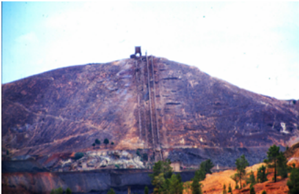
Conductos de gases sulfurosos y chimenea. Esos gases producían abundantes lluvias ácidas. Riotinto (Huelva)
