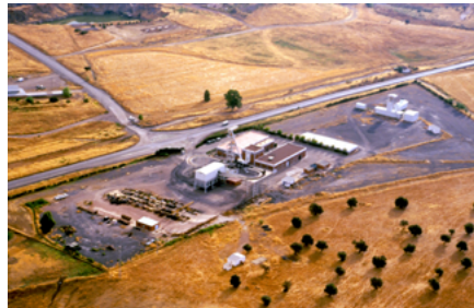
Vista aérea de la mina María la última que se abrió en Europa. Con ella cesó la minería de interior en la comarca del Guadiato. Peñarroya-Pueblonuevo
