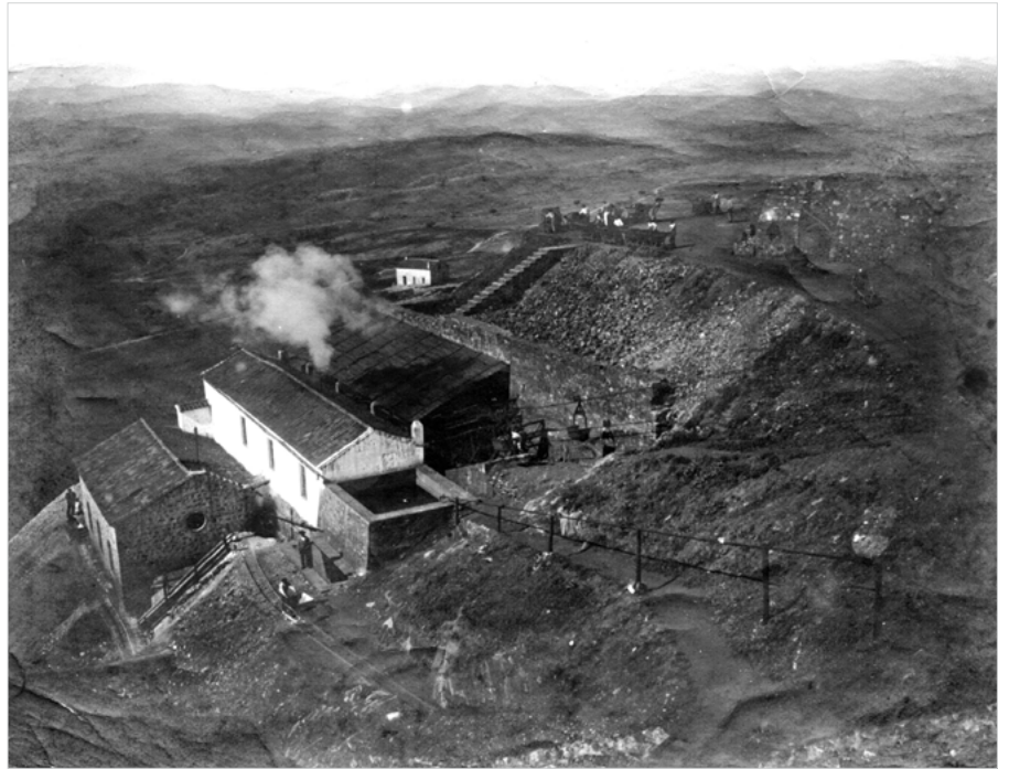
Instalaciones de la mina a finales del siglo XIX. Mina de la Jayona | fuente Archivos de la mina (Anónimo)
