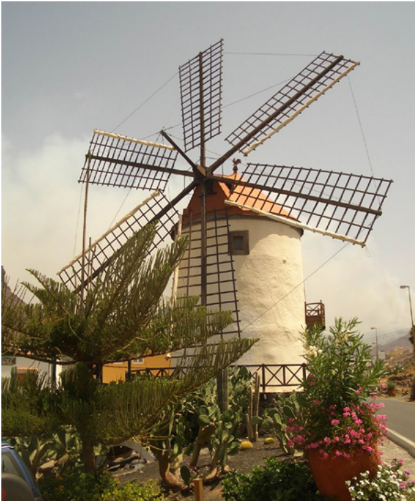
Imágenes 3 y 4] Molino harinero tipo torre de seis aspas. Término municipal de Mogán, Gran Canaria. Fotos: VMCG
