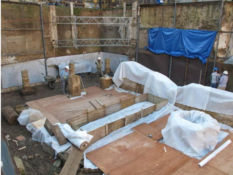
Fig. 17. Protección del yacimiento tras los trabajos de limpieza y tratamiento preventivo/ Estudio Francisco Reina.
