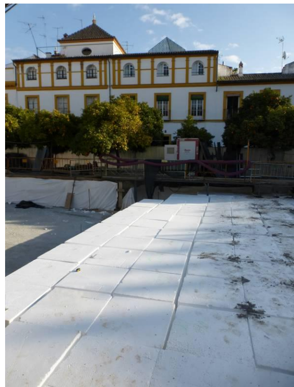
Fig. 18 y 19. Relleno de piezas de poliestireno y acondicionamiento del espacio de la cripta/ Estudio Francisco Reina.
