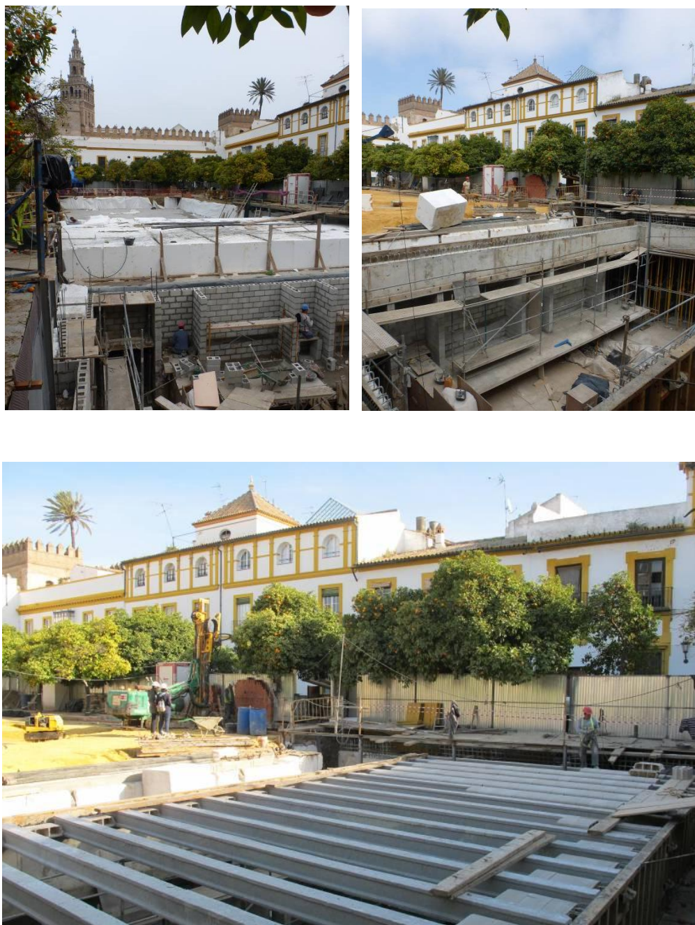
Fig. 29, 30, 31. Imágenes durante la ejecución de las estructuras. Construcción del forjado/ Estudio Francisco Reina.
