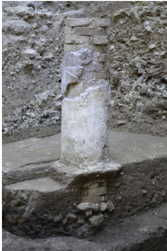
Fig. 15 y 16. Columna de ladrillo, con restos de revestimiento, perteneciente a la crujía sur y muro de adobe / Miguel Ángel Tabales.
