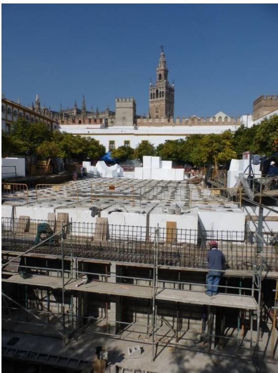
Fig. 18 y 19. Relleno de piezas de poliestireno y acondicionamiento del espacio de la cripta/ Estudio Francisco Reina.
