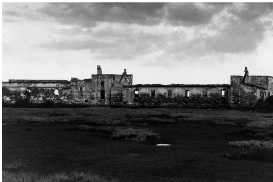
El Molino mareal El Pintado en estado ruinoso | foto Patxi Serveto (Ayamonte, 1996)
