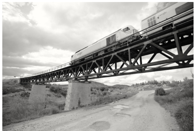
Viaducto del Jandulilla en el término de Úbeda, proyectado por la compañía Fives-Lille en 1890 y puesto en servicio en 1895 para la línea ferroviaria Linares-Almería
