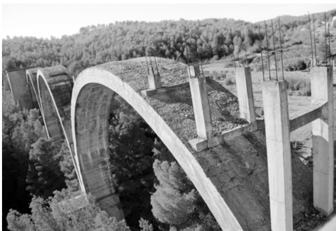
Viaducto inacabado sobre la Rambla del Tollo de Tortuga, conocido como "Puente Huerta Carreras", construido entre 1927 y 1934 para la línea ferroviaria Baeza-Utiel en Villamalea, Albacete | foto Luis Morales Padilla, autor de todas las imágenes si no se indica lo contrario
