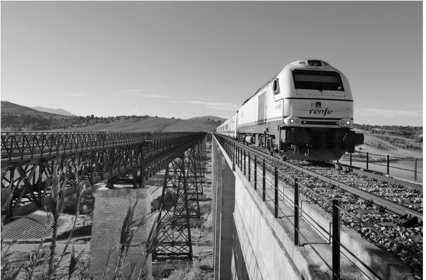
Puente de Hierro Hacho, de 624,60 m de longitud, en Guadahortuna, Granada. A su derecha, un tren TALGO circula sobre el puente de hormigón actualmente en servicio
