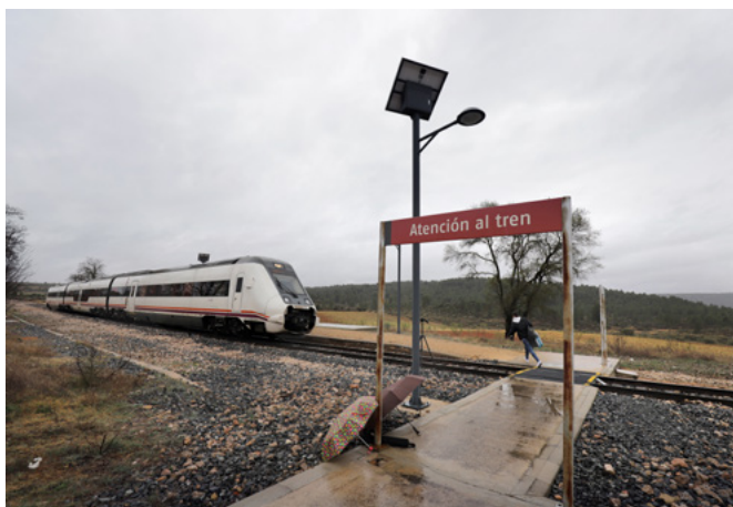
Apeadero de Vállora, Cuenca, tras la demolición de edificios de la estación
